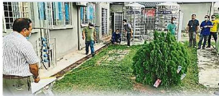
莫哈末阿兹米（左）测量增设水泵及储备水槽地点。
